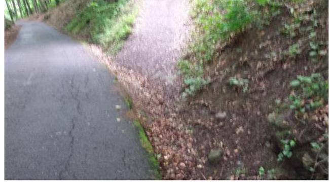
Zwischen Strasse und Kiesweg verläuft eine ca. 20 cm tiefe Entwässerungsrinne. Verletzungsgefahr (Verstauchung Fussknöchel) durch Entwässerungsrinne. Allenfalls kann Rinne mittels Betonrohr überdeckt werden.
