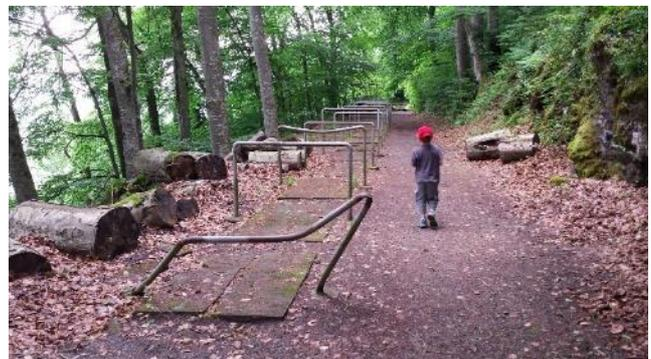
**Hindernisbahn 2:** Teilweise defekte Hindernisse Verletzungsgefahr infolge Betonplatten anstelle von Fallschutzplatten, Holzschnitzel oder Rundsplitt
